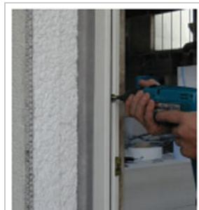
O ultima etapa a fixarii tocoului o reprezinta prinderea suruburilor de montaj, cu ajutorul unei bormasini sau a unei surubelnite electrice, cu cap torx.
